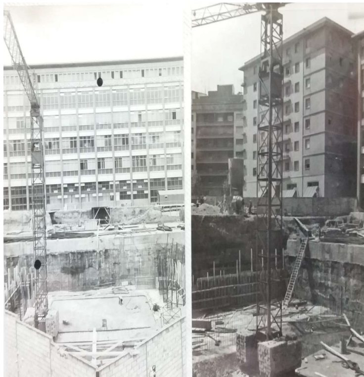
Doc.15:Parròquia en construcció. Any 1970
