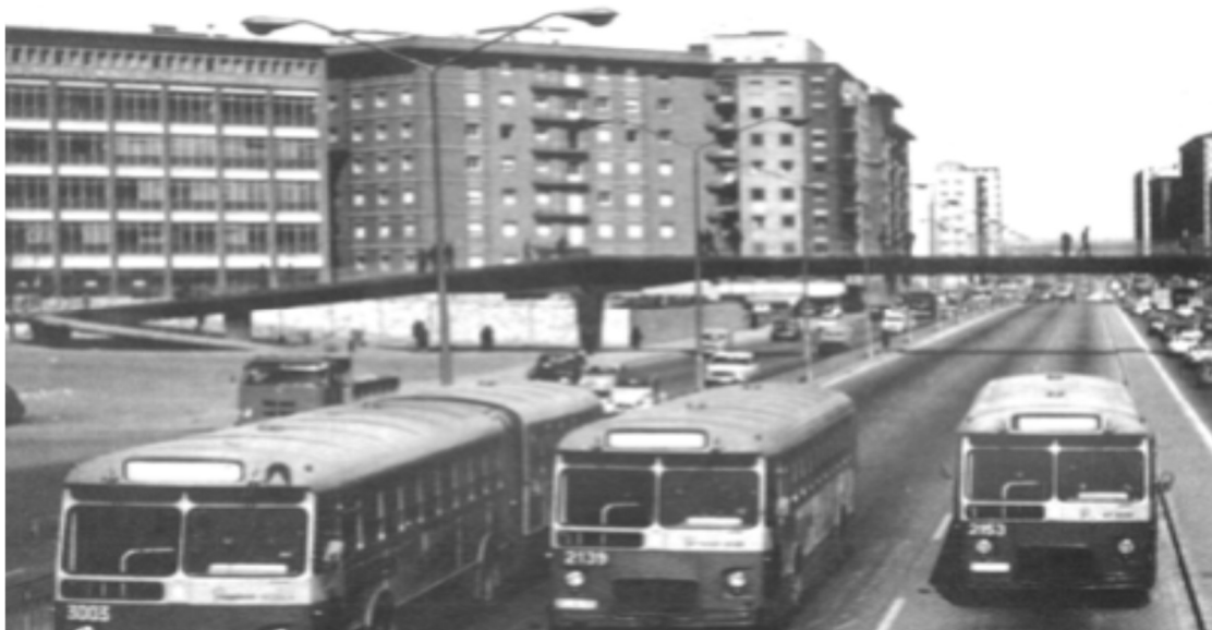
Doc.2: Fotografia de la meridiana cap els anys 70 del segle XX. Es veu el pont i l'església s'està construint.
