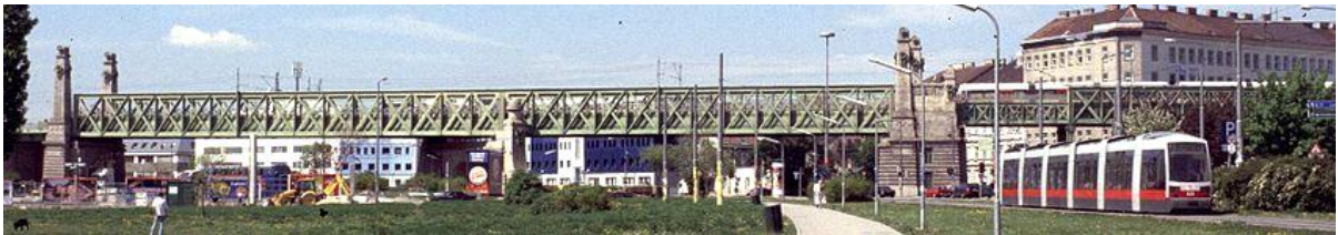
Pont del metro de Viena, Otto Wagner (1894)
